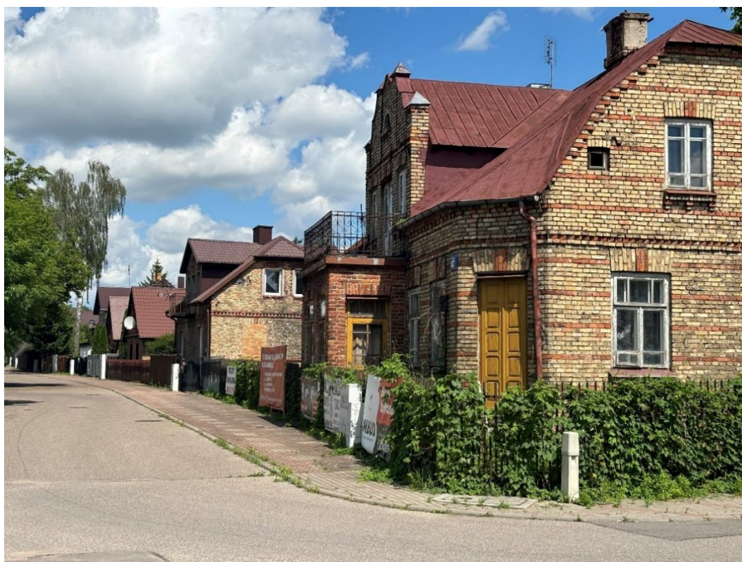
Fot. 2. Zabudowa mieszkaniowa przy ul. Utrata
