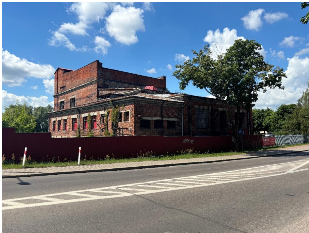
Fot. 1. Zabytkowy budynek elektrowni miejskiej przy ul. Sejneńskiej
